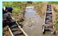
水田魚道の設置
