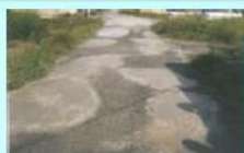
農道の窪みの補修
