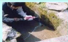
水路のひび割れ補修
