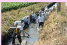
水路の泥上げ
